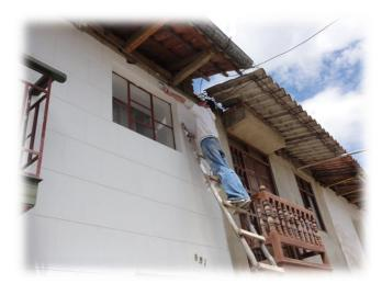
Auch die Hausfassade bekommt einen neuen Anstrich. Zunächst muss die alte Farbe abgekratzt, sowie die Hauswand abgeschliffen werden. Diese Arbeit hatte ich leicht unterschätzt, als ich gesagt hatte "alles kein Problem, ich mach das"...
